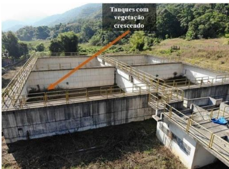
Figura 24 - Tanques da ETE Una com vegetação crescendo
