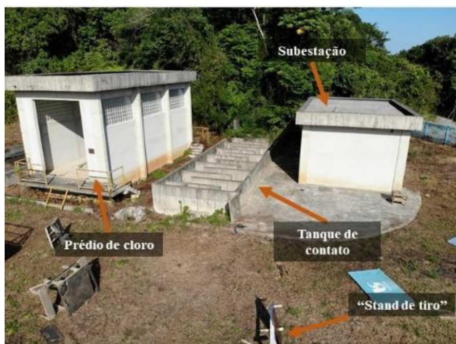
Figura 26 - Destaque para o tanque de contato, o prédio de cloro e a subestação da ETE Una
